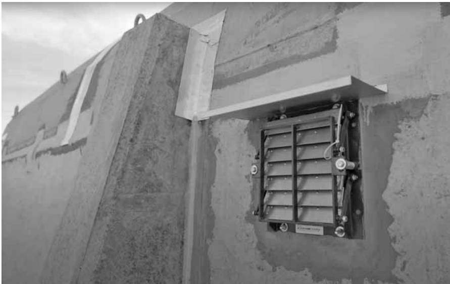
Противибуховий клапан, який захищає від повітряної ударної хвилі
