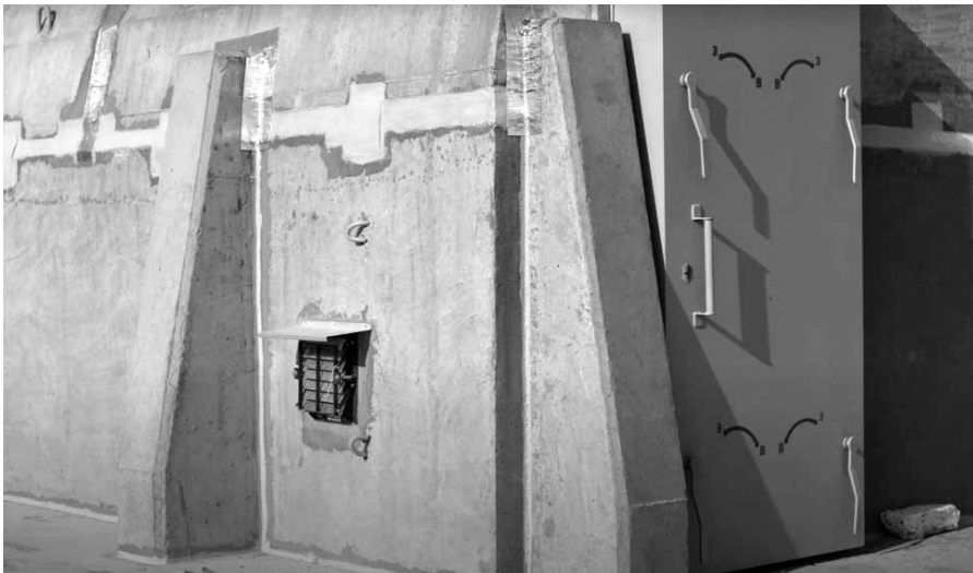
Потужні контрфорси товщиною 300 мм
